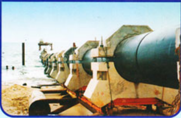
งานวางท่อน้ำในทะเล Ø 1,000 มม. (Submarine intake pipe line)
