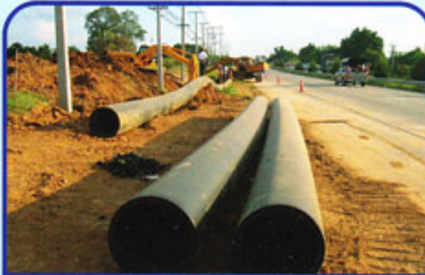
งานติดตั้งท่อในการพัฒนาพื้นที่ในชนบท (Advantage piping installation for rural development)
