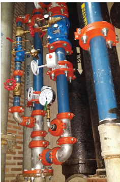
ภาพการติดตั้ง PRV กับท่อ SYLER
